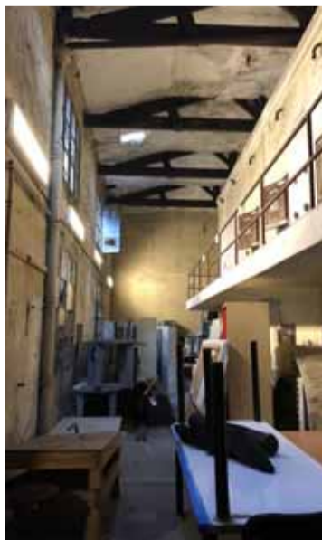
Le programme Aire comprend cet entrepôt, près de la place Nansouty. PHOTO LA FAB
